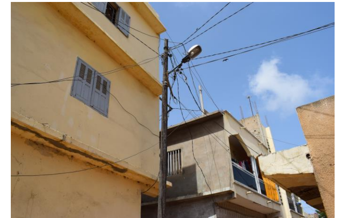
Raccordement artisanal au réseau électrique (Photo USF)
