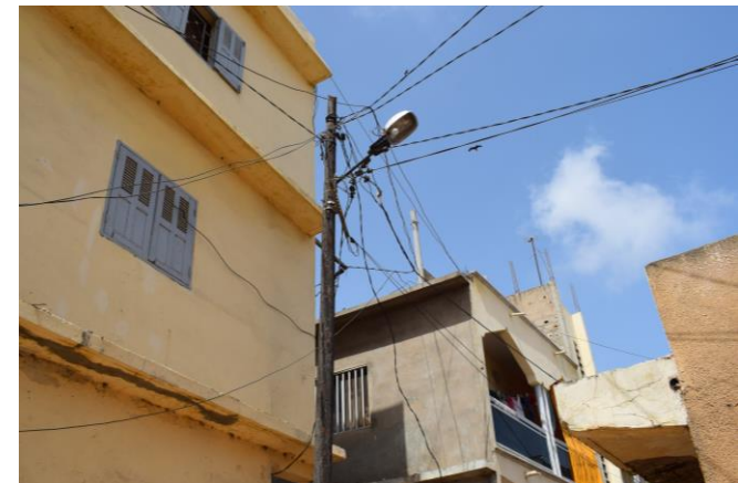
Raccordements électriques artisanaux (Photo USF)
