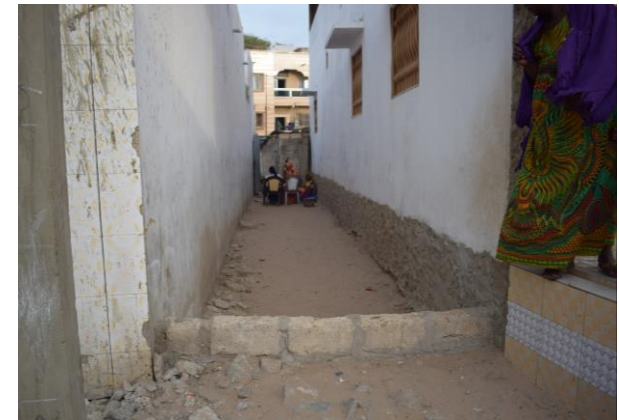
Aménagement succinct face aux inondations (Photo USF)
