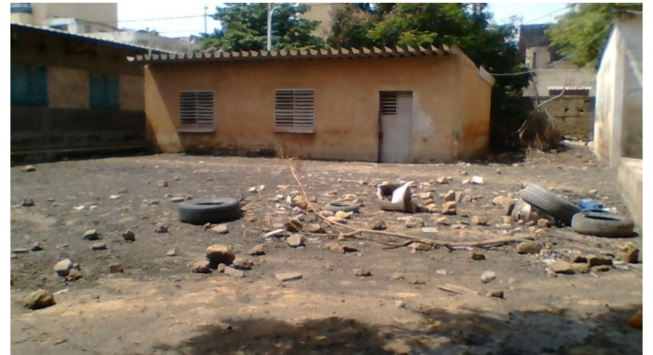
Salle de classe condamnée suite aux inondations récurrentes (Photo archive quartier Medina Pikine)
