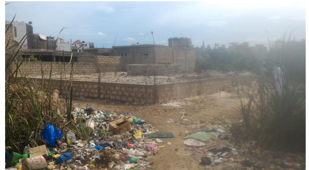
Construction sans autorisation (Photo USF, 2018)
