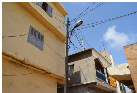
Raccordement artisanal au réseau électrique (Photo USF)
