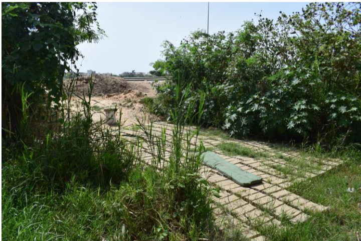
Dépôt de parpaings pour future construction (Photo USF)
