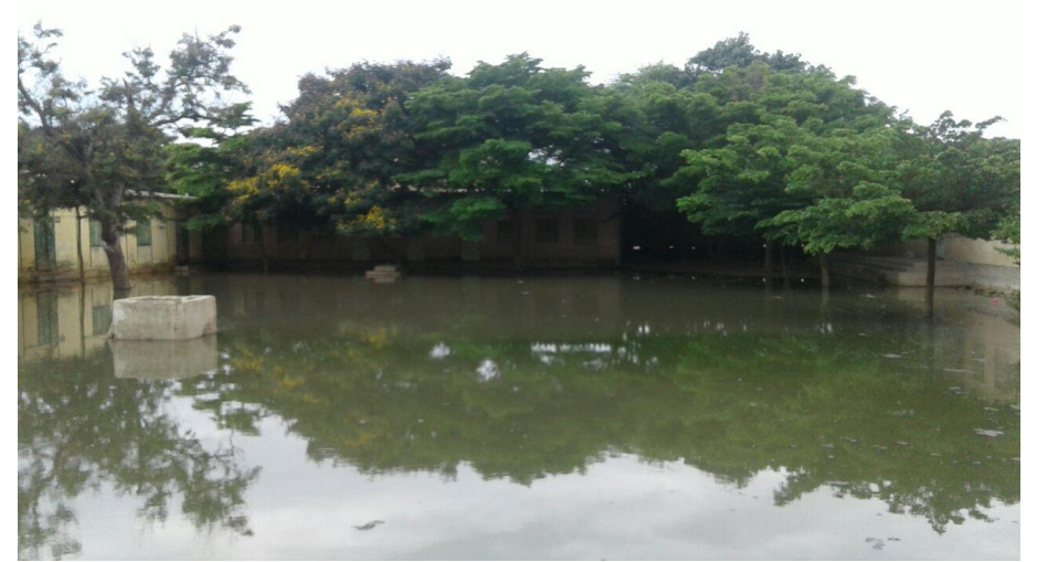
Cour de récréation sous les eaux (Photo archive quartier Medina Pikine)
