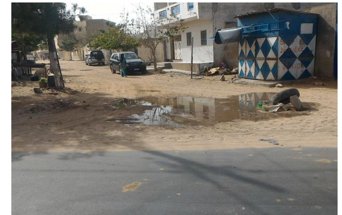
Débordement des eaux usées sur la voie publique (Photo USF)
