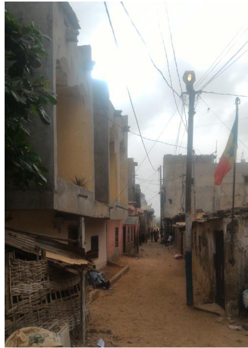
Raccordement artisanal au réseau électrique (Photo USF)
