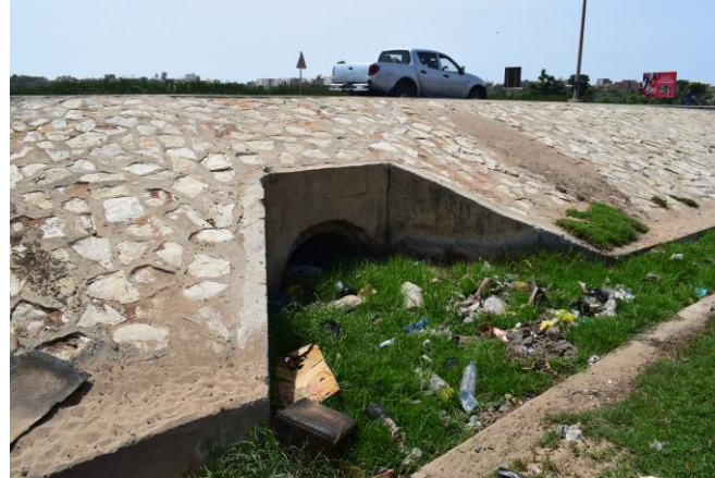
Obstruction du réseau d'évacuation des eaux (Photo USF)
