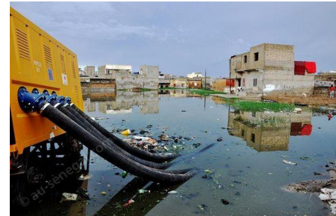
Pompage inondations 2012, Pikine (Source : AuSénégal)
