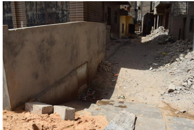
Encombrement des voiries (Photo USF)
